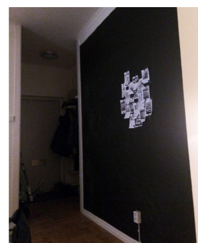
Ostuderad enkelgipsvägg, ger överhöring mellan rum.
