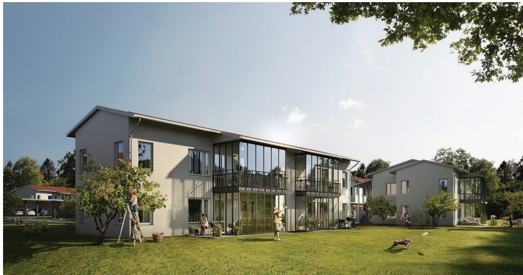
Originalhuset, arkitekt: Efem Arkitektkontor
