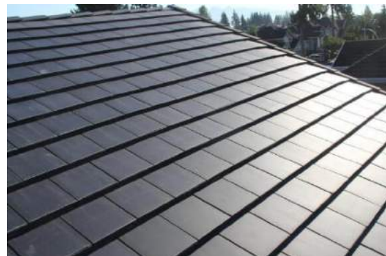
Solpanel; Nyedal solenergi.
