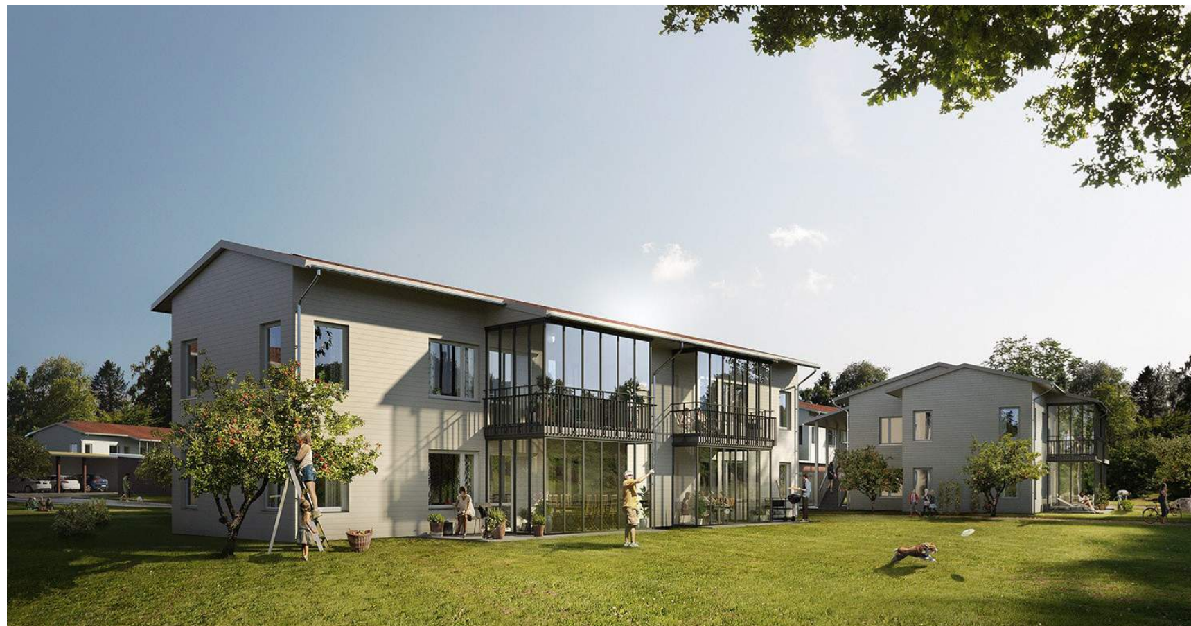
Originalhuset, arkitekt: Efem Arkitektkontor
